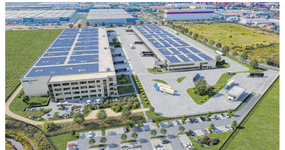
Letzte große Baulücke: Die Gesamtfläche des Bauprojekts von Panattoni für die Nagel-Group umfasst 36.600 Quadratmeter.
